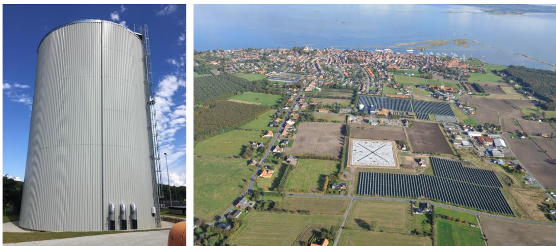
Figur 38: Akkumuleringstank til fjernvarme og Marstal solvarmeanlæg med damvarmelager på 75.000 m 3 .
